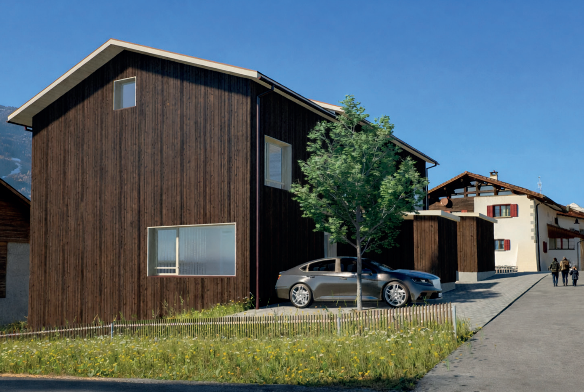
ImHof Blick von Süden mit Hauseingängen
